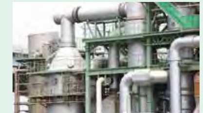
石油精製プラント内面
